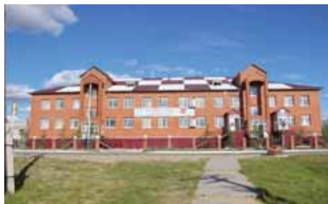
Здание терапевтического, родильного, хирургического отделений
