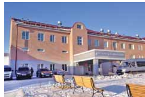
Здание ОГБУЗ «Ольхонская районная больница»
