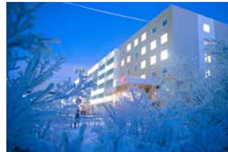
Здание ГБУ РС (Я) «Айхальская городская больница»
